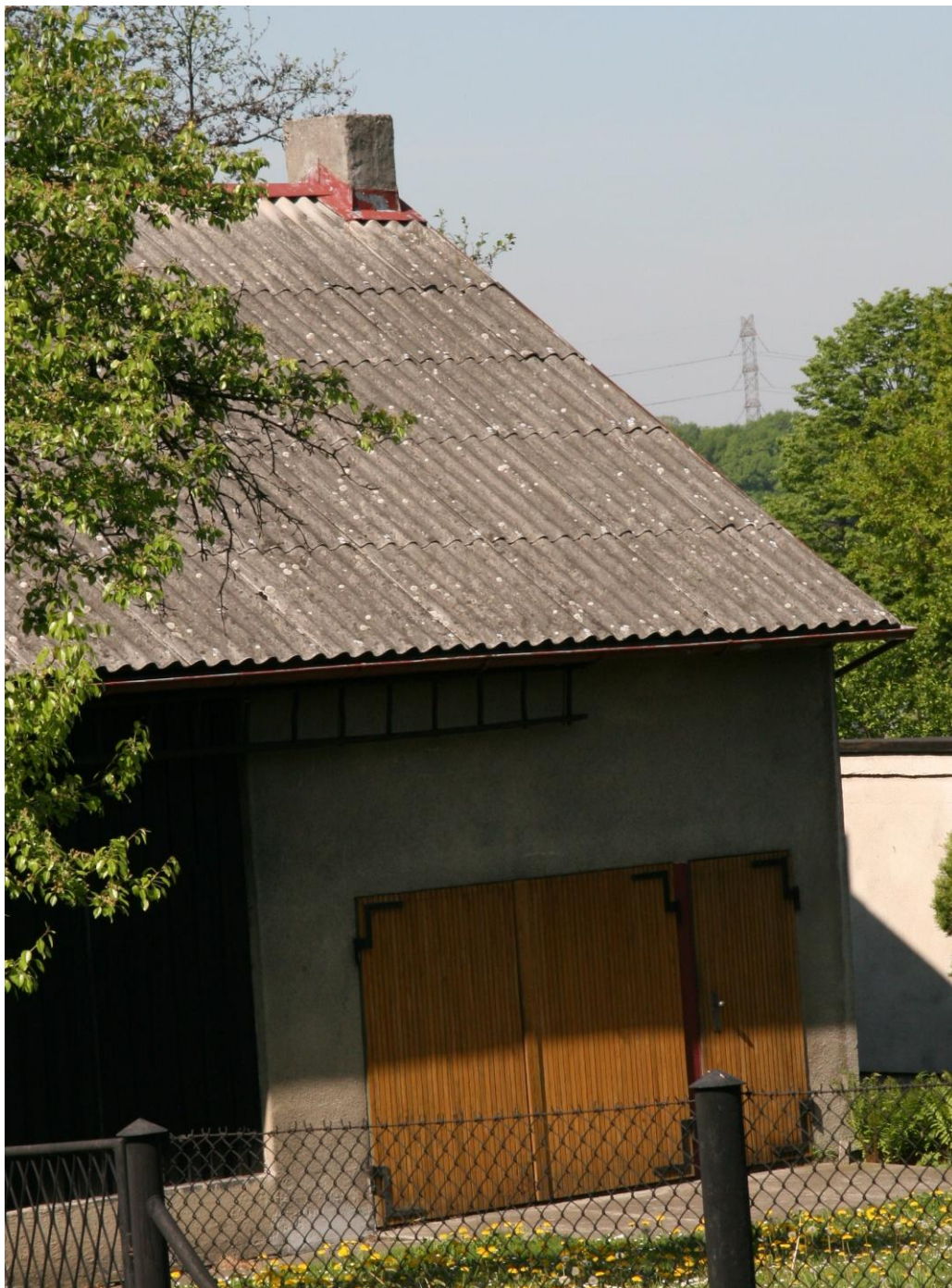
Rysunek 3 Dach pokryty płytami azbestowymi falistymi
