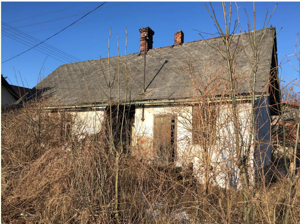
Rysunek 25 Zaniebany budynek pokryty powłokami azbestowymi przy ulicy Wyzwolenia w Buczkowicach
